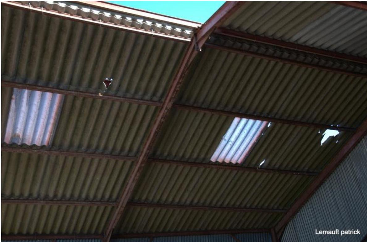
**Photo 5** : sur ce même hangar, retour d'impact des plaques de fibrociment
